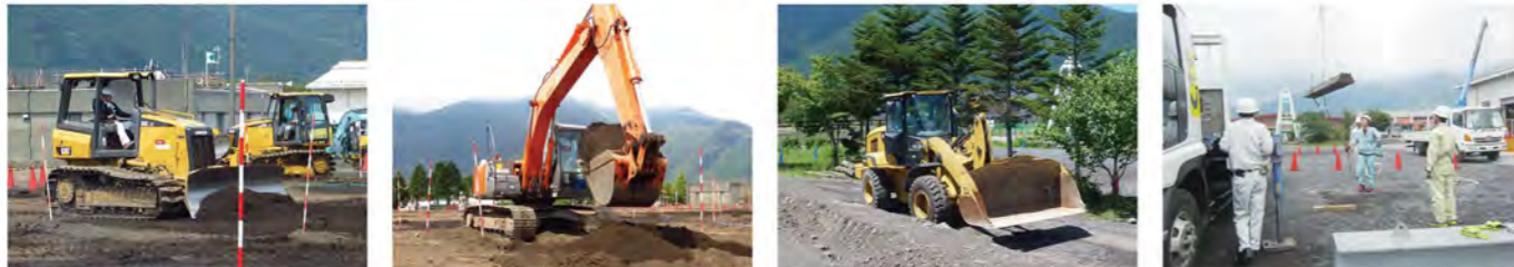
ブルドーザーでの整地
