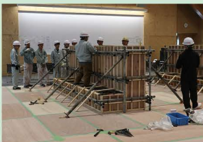
鉄筋型枠実習
