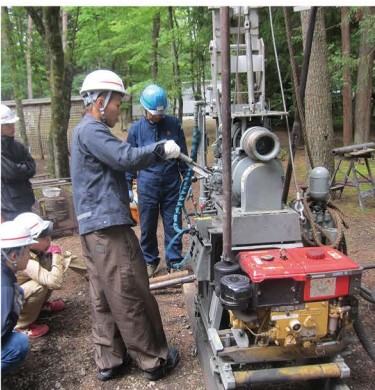
地盤調査実習
