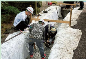
排水施工実習
