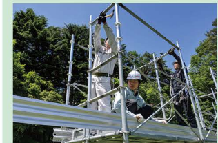
建設足場実習
