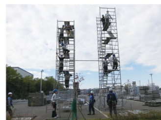
足場 (イントレ) 組立て
