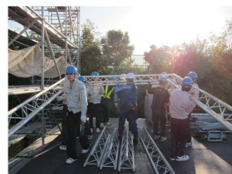
トラス組立て
