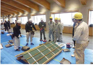
瓦桟（かわらざん）取付け
