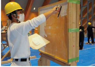
タイル下地塗り
