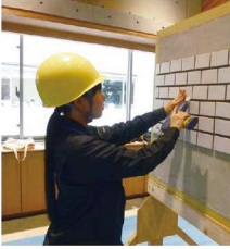
圧着・密着工法のタイル張り
