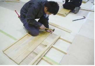
フローリング張付け
