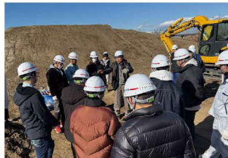
護岸工事 現場見学
