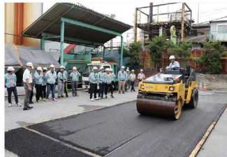
舗装作業実演見学
