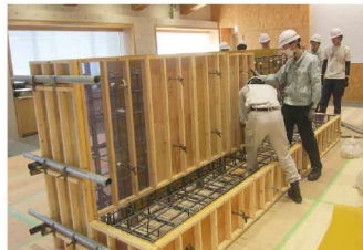
鉄筋型枠実習
