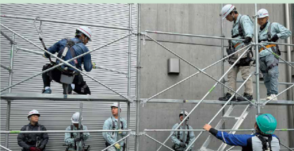
建設足場実習
