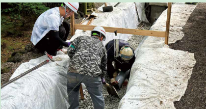
排水施工実習
