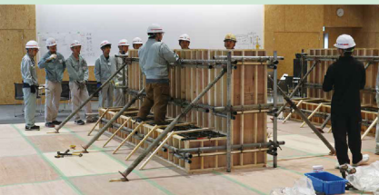
鉄筋型枠実習
