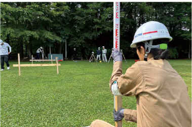
排水施工実習 丁張設置作業
