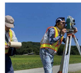
トータルステーションによる観測
