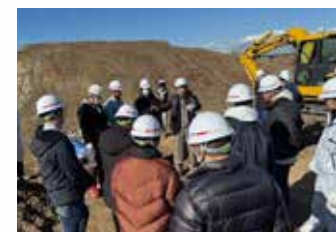
護岸工事 現場見学
