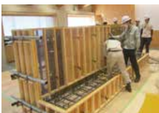
鉄筋型枠実習
