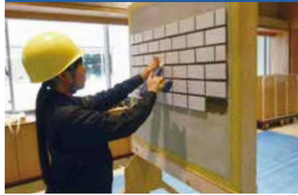
圧着・密着工法のタイル張り
