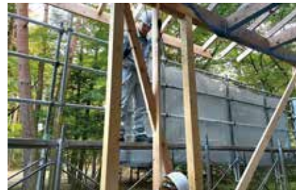
筋違・間柱の取付け
