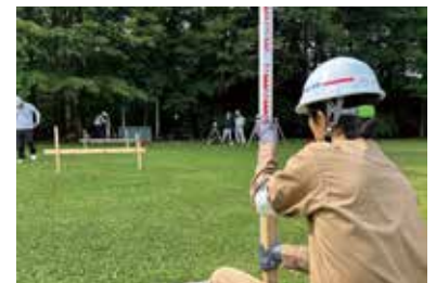
排水施工実習 丁張設置作業
