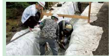
土木施工実習
