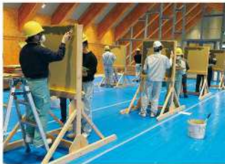
プラスター塗り仕上げ
