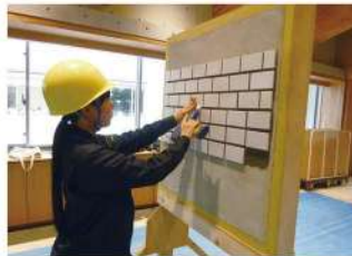
圧着・密着工法のタイル張り
