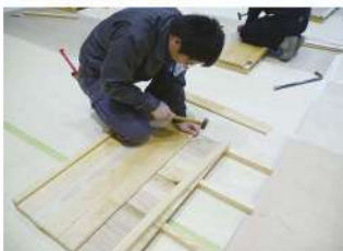
フローリング張付け
