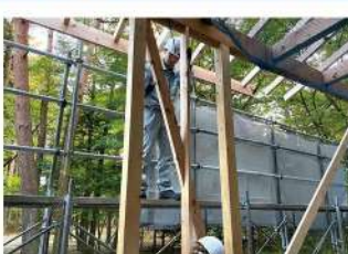
筋違・間柱の取付け
