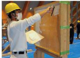
タイル下地塗り
