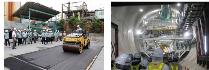
舗装作業実演見学
