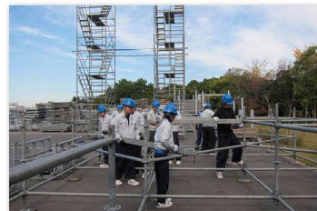
仮設安全管理 レイヤーステージ組立て
