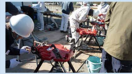
配管施工実習
