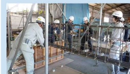
基礎躯体実習
