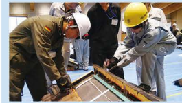
屋根かわり工事実習
