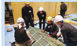
施工専攻実習 (屋根から工事実習)
