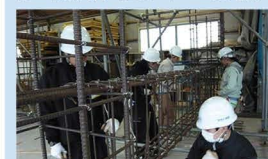
施工管理実習 基礎躯体
