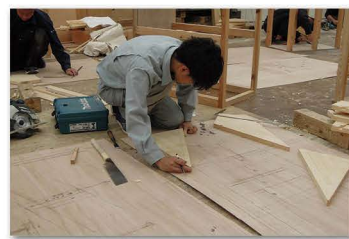
階段 段板の現寸図と墨付け加工
