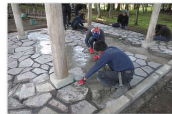
造園施工実習Ⅰ・Ⅱ
