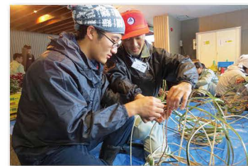
造園施工実習Ⅰ・Ⅱ
