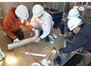
換気ダクトの施工
