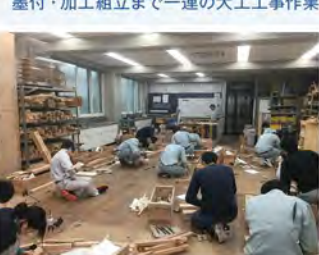
実習の作業風景
