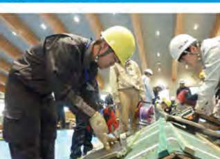
屋根から工事
