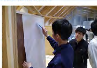
内装壁仕上げ工事クロス張り
