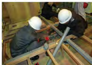
排水管の据付け
