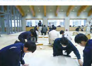
内装床仕上げ工事長尺シート張り
