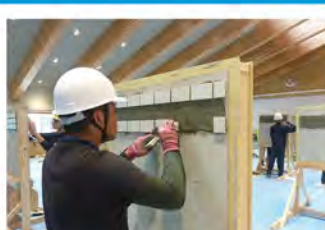
壁タイル工事
