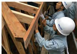
破風板の取付け
