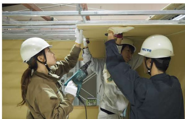
内装施工管理実習
