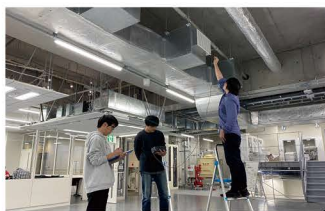
建築環境測定 (風速測定)
